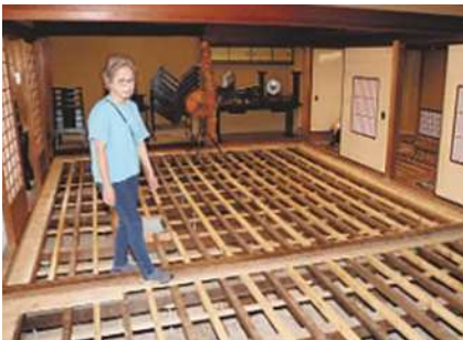
浸水被害を受けた床の乾燥風景
